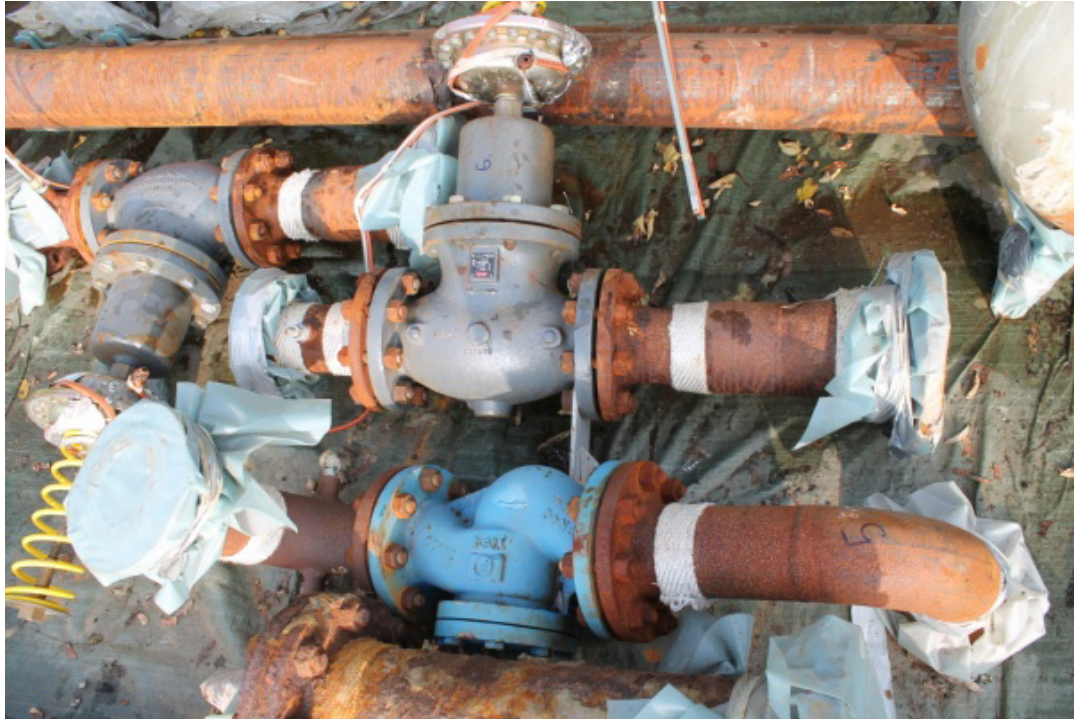
Abb. 11: Bereitstellung von Bauteilen aus einer geothermischen Anlage zum Einschmelzen. Zur Verhinderung von Aktivitätsaustrag sind die Rohröffnungen verschlossen. Die Außenseiten der Rohre sind nicht kontaminiert.
